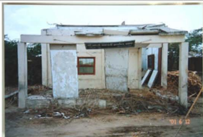
再建するカルゴパンチャヤティー小学校（正面）
